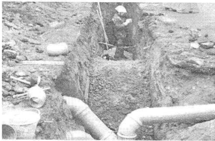
Via libera ai lavori per la rete fognaria a Bruscé
